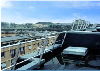
Für seine Festgeländer hat Tubesca-Comabi drei Arten **Befestigungen** entwickelt: Z-förmige, Platinen-förmige und wandmontierte Pfosten bzw. Träger zur Verankerung an verschiedensten Aufnahmestrukturen (Dachumrandungen aus Stahl, Beton, oder Umlaufschienen). Sobald die Befestigungsart bestimmt ist, gilt es nur noch, je nach Ästhetik des Gebäudes, zwischen geraden oder geneigten Geländerpfosten zu wählen.
